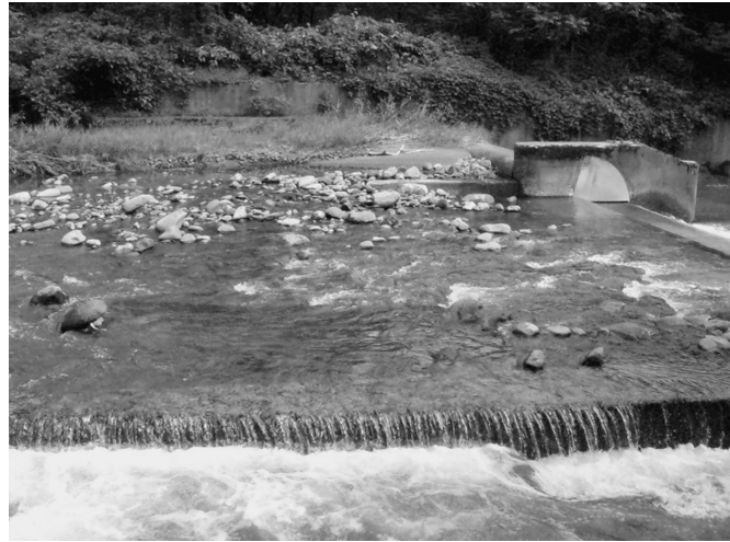
写真6 田山堰頭首工①
