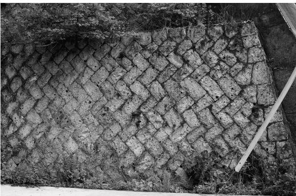
写真7 アブ石を使った石垣 (大鰐町内日精寺の下)
