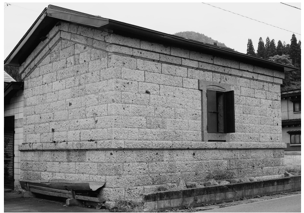
写真6 アブ石を使った石蔵 (大鰐町早瀬野地区, 昭和38年建造)
